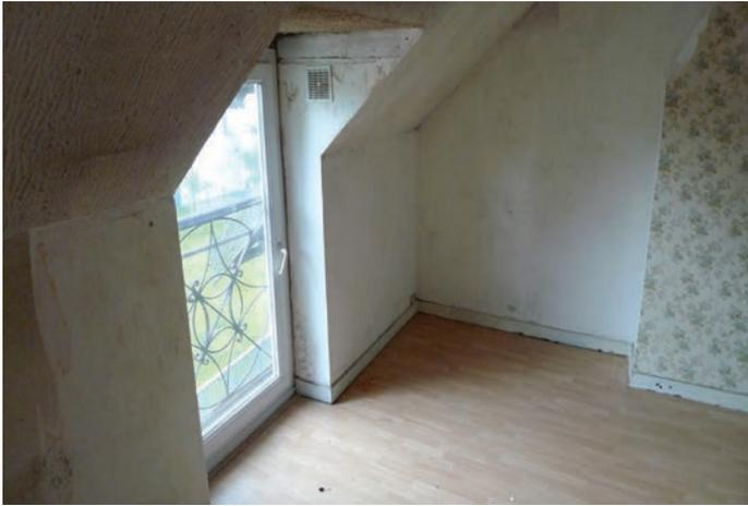
R+2 log. 3 : Lucarnes à vérifier, infiltrations visibles de l'intérieur.
