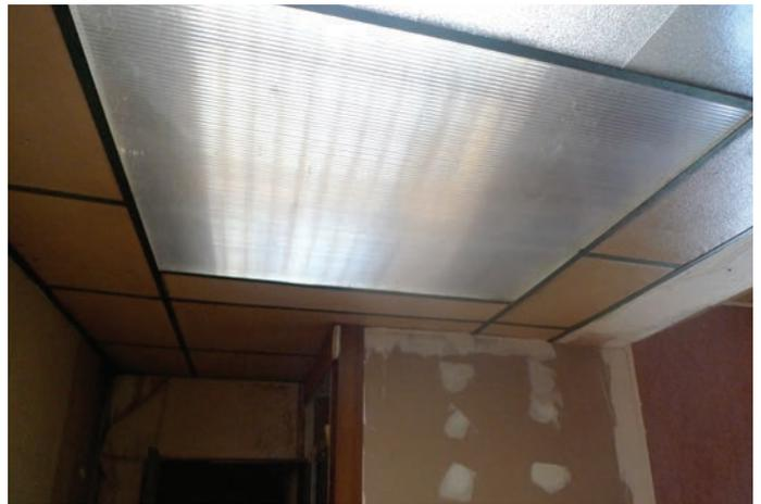
RDC salle d'eau : Le faux plafond est entièrement à déposer (éléments en polycarbonate à déposer) afin de constater l'état de la charpente. Etudier la possibilité d'éclairer naturellement les pièces de vie.
