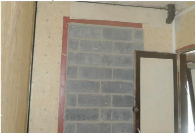
RDC salon : Réseau à supprimer (évacuation supposée du toilette du R+1) celui-ci n'est pas visible en façade avant, soit celui-ci n'est pas utilisé soit celui-ci passe dans l'épaisseur du mur comme dans le cas de la douche.
