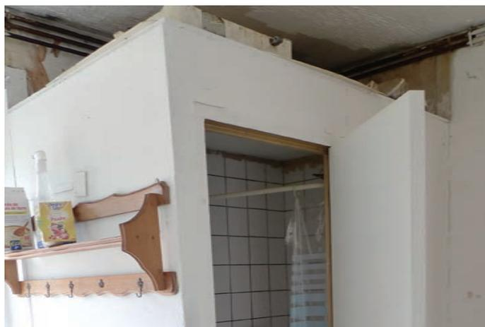
R+1 cuisine log. 2 : Les cloisons de la «salle d'eau» doivent être démolies, les réseaux sont à réorganiser en fonction de l'état projeté.
