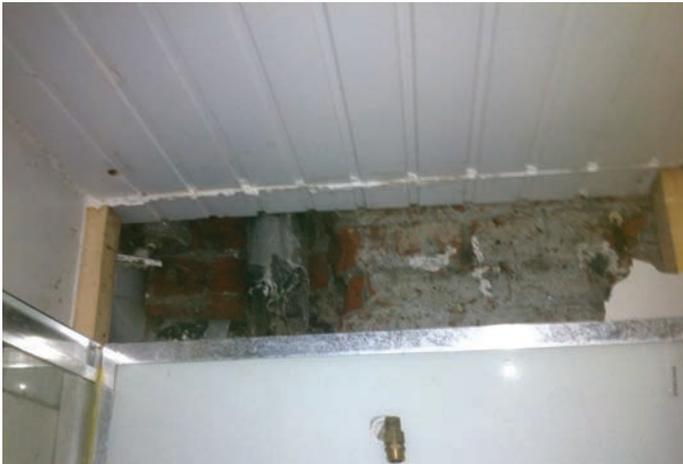
RDC salle d'eau (douche) : Présence de deux descentes dans l'épaisseur de la maçonnerie, la première est la descente visible en façade arrière du toilette en R+2. Pour la seconde le mystère demeure. La maçonnerie est très humide.
