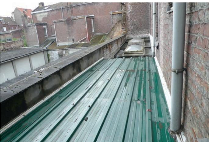
Couverture de l'extension à déposer, en profiter pour éclairer les pièces en RDC.
