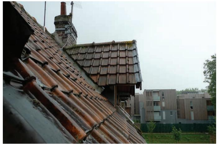
Cheminée à rejointoyer, zinguerie et solins à reprendre entièrement. Antenne à déposer. Pas d'accès existant aux combles perdus, Il est possible que des dégâts sur la charpente soient constatés lors des travaux (prévoir dans le chiffrage)
