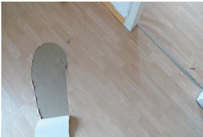
R+2 log. 3 : Le plancher a été doublé récemment, déposer le sol souple et prévoir la pose d'un parquet sur l'ensemble de l'étage.
