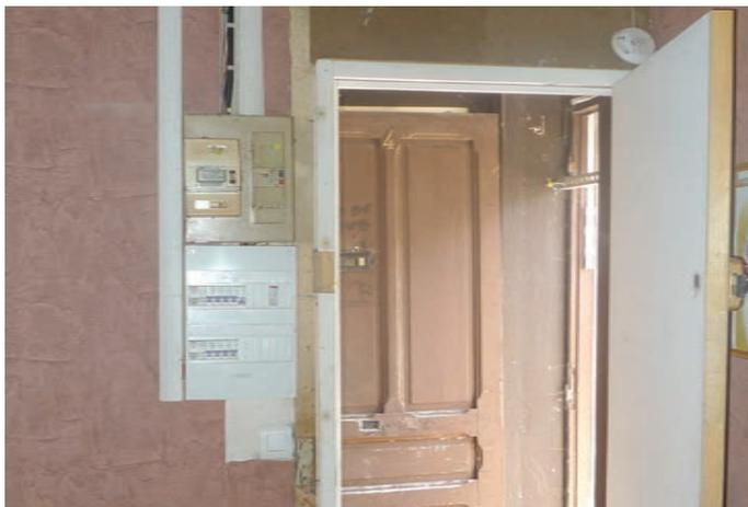
RDC séjour : Installation électrique à refaire entièrement selon les besoins du projet. Au premier plan la porte est à déposer, celle-ci est mal posée (en applique).
