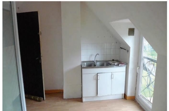
R+2 cuisine log. 3 : Ventilation à déposer, menuiserie PVC à remplacer par des modèles en bois avec ventilation intégrée.
