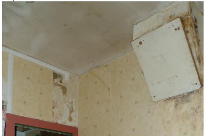
RDC salon : Le conduit de cheminée présente une infiltration importante soit réutiliser le conduit pour le chauffage soit bouchée cette cheminée, voir la démolir.
