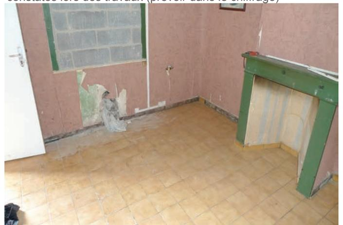
RDC séjour : Sous la menuiserie la maçonnerie doit être comblée (ventilation). Etudier la possibilité de supprimer la cheminée (échelle cheminée / pièce disproportionner). Etudier la possibilité d'isoler la dalle basse sur terre-plein.
