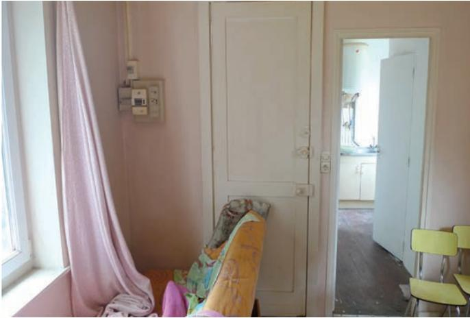
R+2 pièce de vie log. 2 : Installation électrique à déposer. Le plancher présente de légères déformations, plancher existant à rénover.
