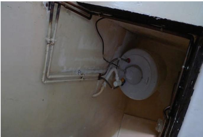
R+2 escalier log. 3 : Présence de ballons ECS dans chaque logement, repenser la production ECS. Élément à déposer. Réseaux à déposer également.
