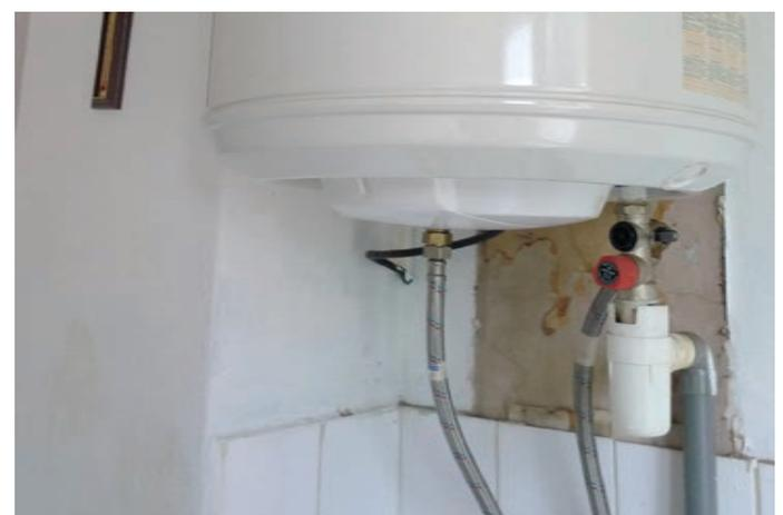
R+1 cuisine log. 2 : Présence de ballons ECS dans chaque logement, repenser la production ECS, élément à déposer.
