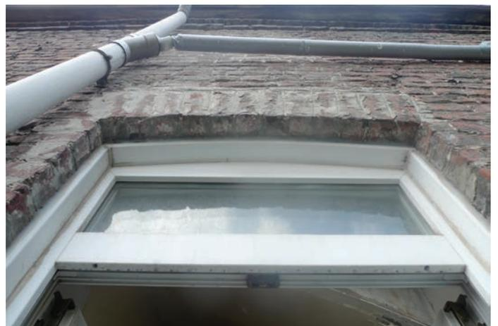
Evacuation des eaux usées à déposer et à séparer des descentes d'eau pluviales. Maçonnerie à reprendre en fonction. Menuiseries à vérifier (pose et étanchéité à l'air).
