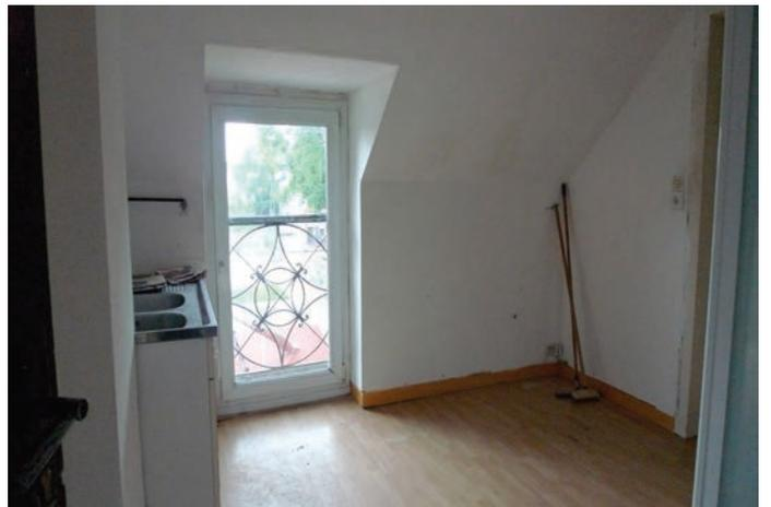
R+2 cuisine log. 3 : Menuiserie PVC à remplacer par un modèle en bois. Garde-corps à reprendre entièrement (anti-rouille, peinture, lisse bois et fixation).
