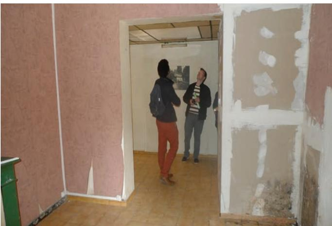
RDC séjour : Présence de moisissures sur le doublage derrière la douche (présence de réseaux derrière celui-ci en l'état difficile de voir d'où vient l'humidité).
