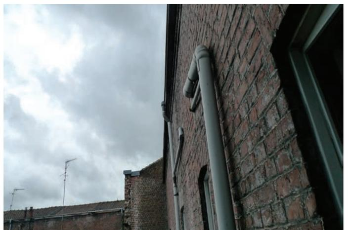
Façade arrière à rejointoyer ou à doubler par l'extérieur (distribution verticale en façade arrière). Réseau à simplifier. Chéneau à vérifier.
