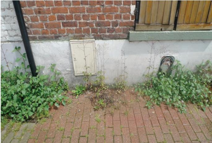
Présence d'une arrivée de gaz dans le soubassement, à utiliser pour les besoins du projet.
