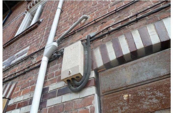
Evacuation des eaux usées à déposer et à séparer des descentes d'eau pluviales.
